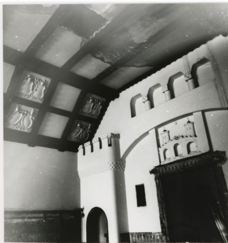
Obr. 1: Původní interiérová fotografie s viditelnými poškozeními a problémy s expozicí.
